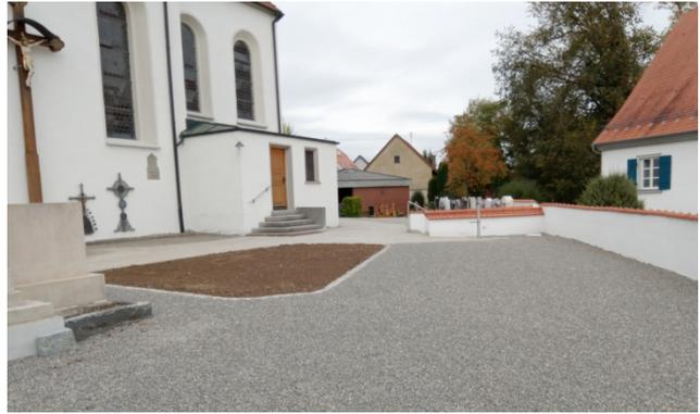
Auch der Bauabschnitt 2 wurde in einem Zug mit angehängt, da der bisherige Weg zu schmal war und auch ziemliche „Gebrauchsspuren“ aufwies. Der neue Weg ist nun so breit und stabil ausgeführt, dass er u.a. im Winter mit dem Räumfahrzeug vom Bauhof geräumt werden kann.
